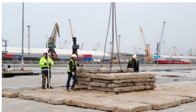
Fot. 5. Obciążenie próbne grupy 4 kolumn na placu manewrowym przy zastosowaniu żelbetowych płyt betonowych
