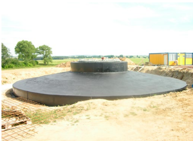
Fot. 11. Fundament nośny pod wieżę elektrowni wiatrowej, Dobin koło Wąłcza
