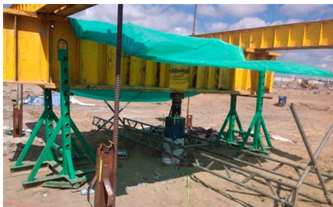
Fot. 3. Stanowisko badawcze do próbnego obciążenia pojedynczej kolumny
