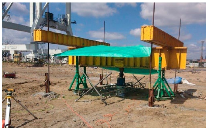
Fot. 2. Obciążenie próbne kolumny nr 1755
