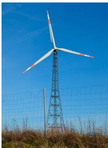
Fot. 10. Wieża kratownicowa
