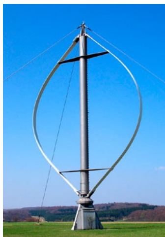
Fot. 7. Turbina Deriusa: 300 kW średnica 17 m; H/D = 2,8 [15]
