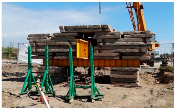
Fot. 4. Obciążenie balastem kolumny w obszarze drogi dojazdowej
