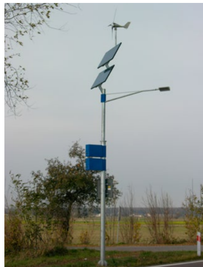
Fot. 13. Autonomiczna mikrosiłownia wiatrowa z panelami PV
