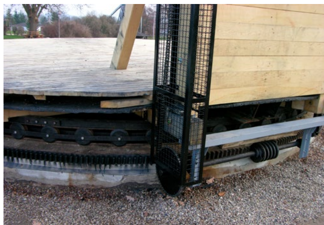
Fot. 1. a), b) Wiatrak holenderski oraz mechanizm samoczynnego naprowadzania na wiatr (XIX wiek, Woldeck, Niemcy)
